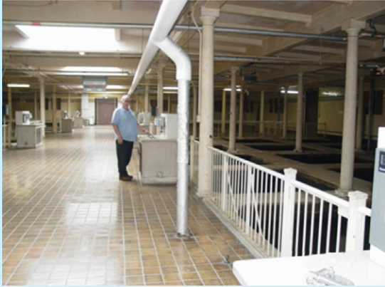
Pre-construcción de la galería de filtros
